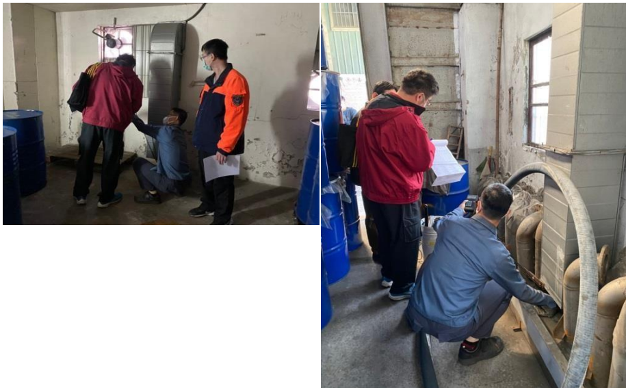
抽氣設備風量測定
