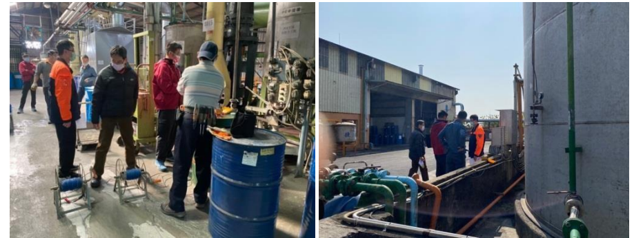
設備接地測試
