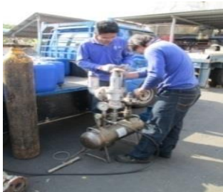
裝設壓力測試設備
